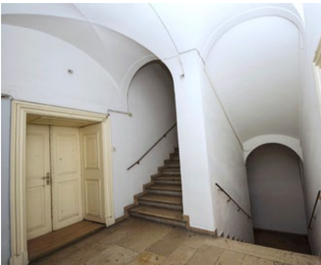
4. Podest stubišta u prvom katu (foto: N. Vasić, 2016.) Staircase landing on the first floor
