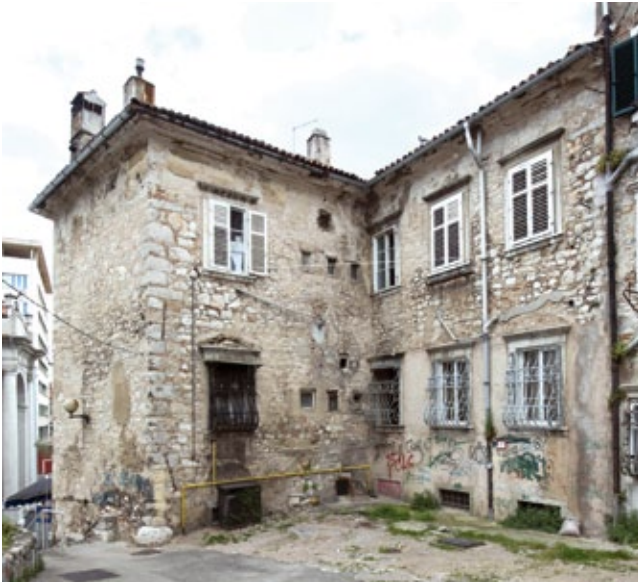
3. Palača Benzoni: sjeverno pročelje palače (foto: N. Vasić, 2016.) Benzoni Palace, north façade
